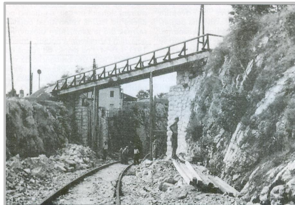
Izgradnja željezničkog nadvožnjaka pred Sušakom
